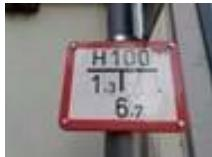
Auf dem Schild ist immer ein „T“-förmiges Zeichen abgebildet. Diese Striche des „T“ geben an in welcher Richtung - die Zahlen in welchem Abstand – zum Schild sich der Hydrant befindet. In diesem Fall befindet sich der Hydrant 1,3 Meter links und 6,7 Meter vor dem Schild.
