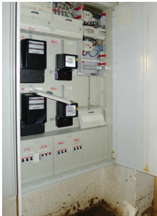
Überfluteter Sicherungskasten in einer Erdgeschosswohnung
