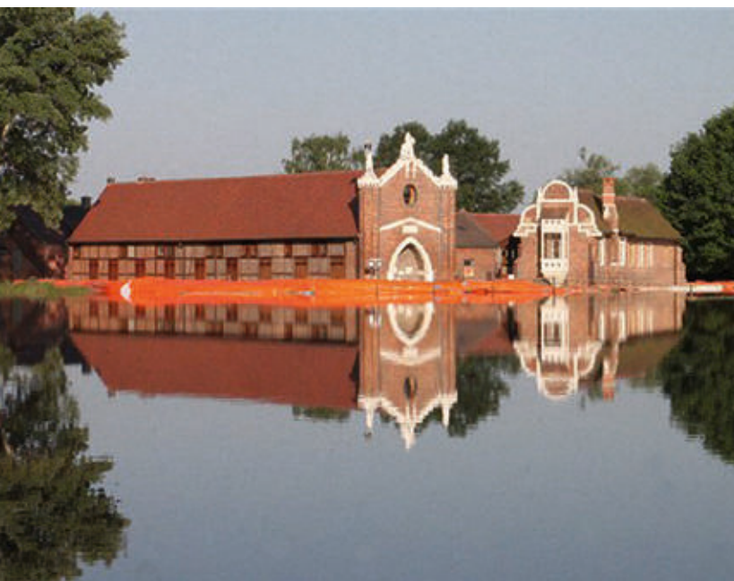
Objektschutz mit mobilem wassergefülltem Schlauchsystem
