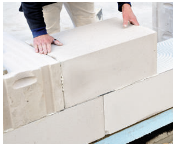
Mauerwerk aus Porenbeton-Plansteinen
