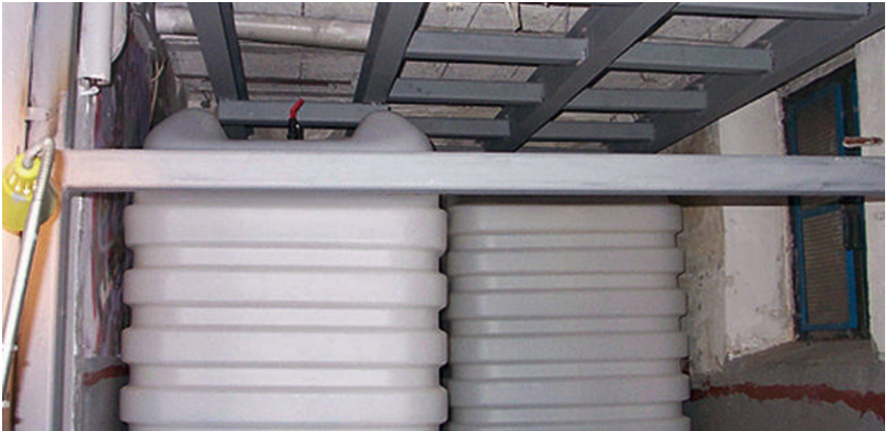
Heizöltankanlage mit Auftriebssicherung
