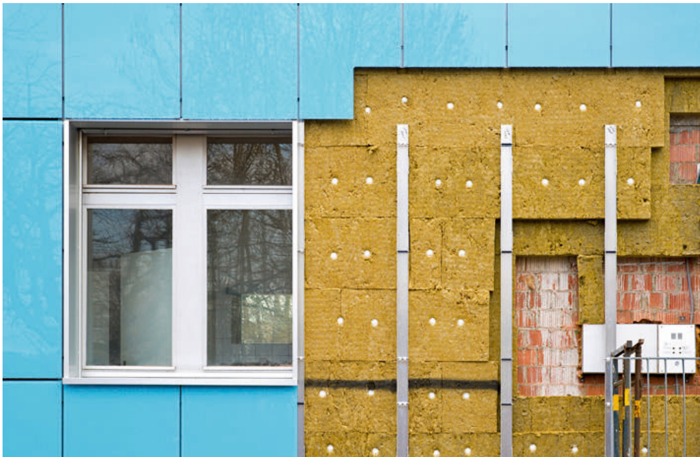
Hinterlüftete Fassadenkonstruktion
