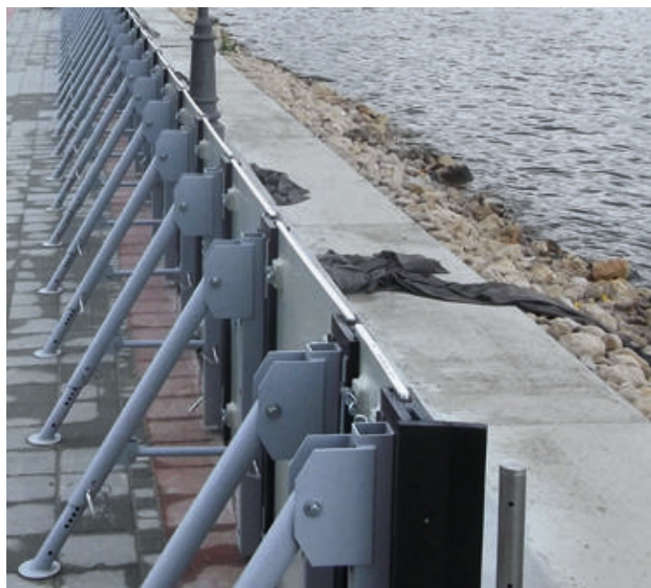
Hochwasserschutz mit Hochwasserschutzplatten aus Kunststoff
