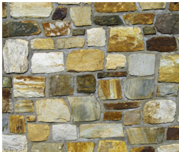
Unregelmäßiges Natursteinmauerwerk
