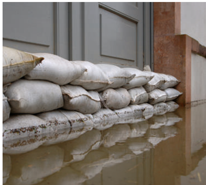
Notfallmäßiger Objektschutz mit Sandsäcken
