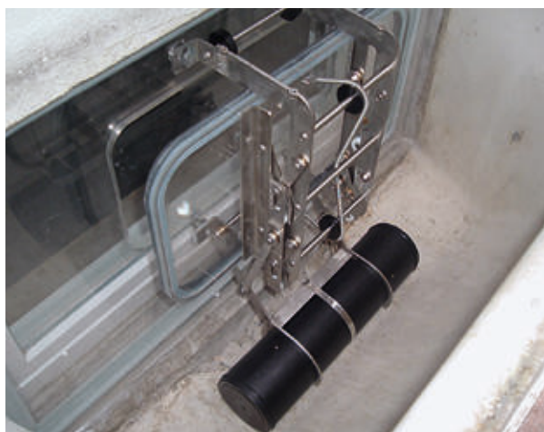
Automatisch schließende Vorsatzscheibe
