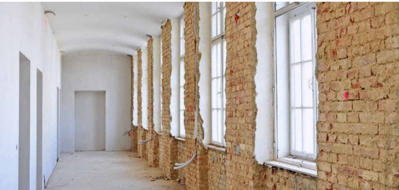
Entfernter Putz zur besseren Trocknung einer Außenwand
