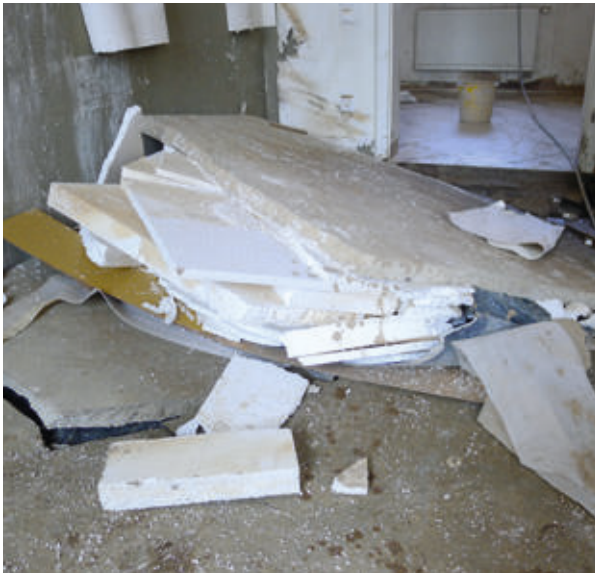
Aufgeschwommene Fußbodenkonstruktion
