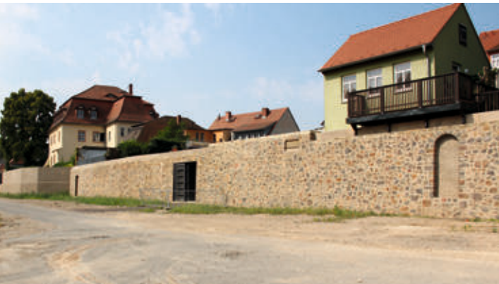
Integrierter Hochwasserschutz in der historischen Stadtmauer ...
