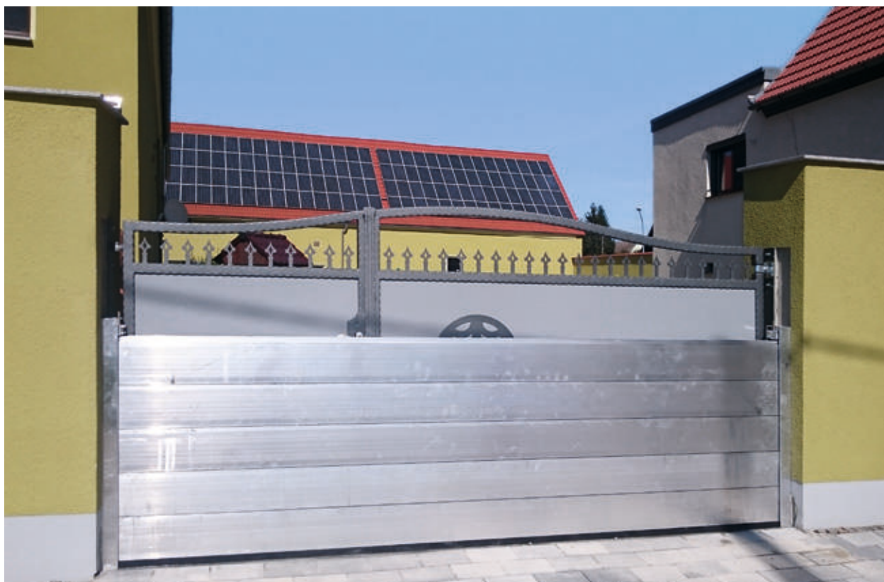
mobiler Hochwasserschutz mit Dammbalken
