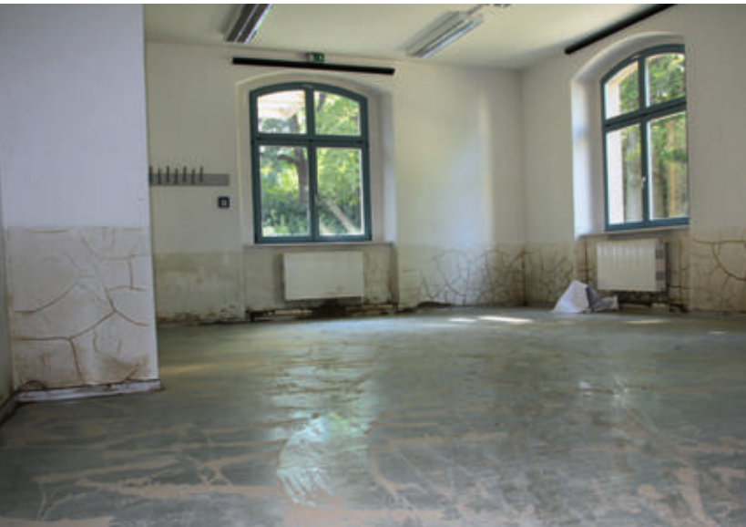
Durchfeuchtete und verschmutzte Außenwände nach Überflutung
