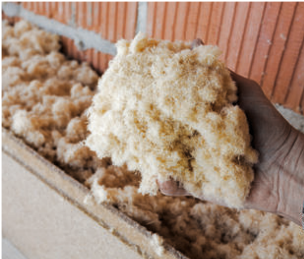
Holzweichfasern für die formatvariable Wärmedämmung von Hohlräumen
