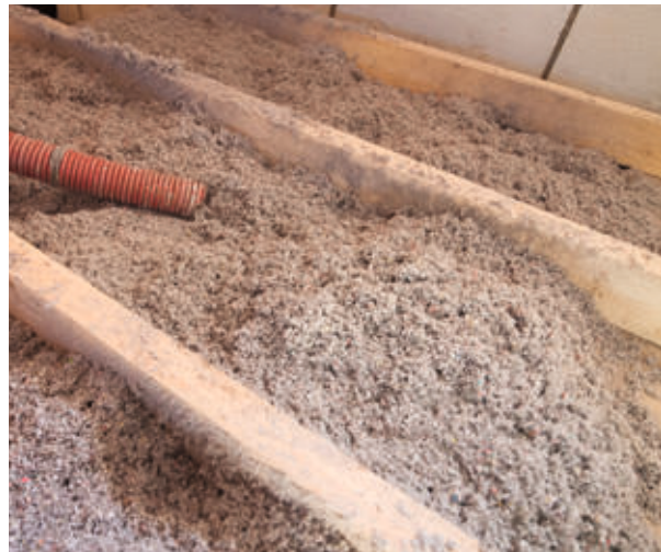
Anwendung von Zelluloseflocken im Fußbodenbereich
