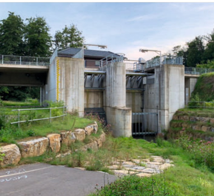
Verschlussbauwerk eines Hochwasserrückhaltebeckens
