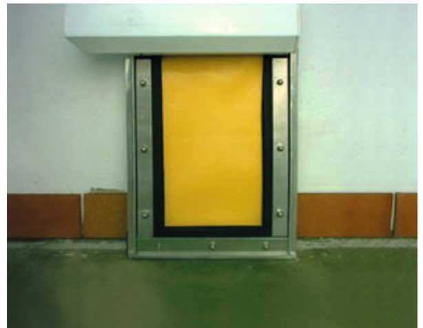
Folienabdichtung für Gebäudeöffnungen
