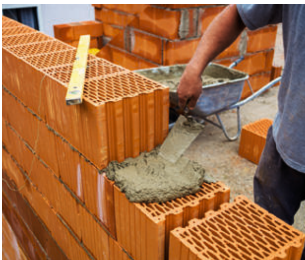
Mauerwerk aus Hochlochziegeln
