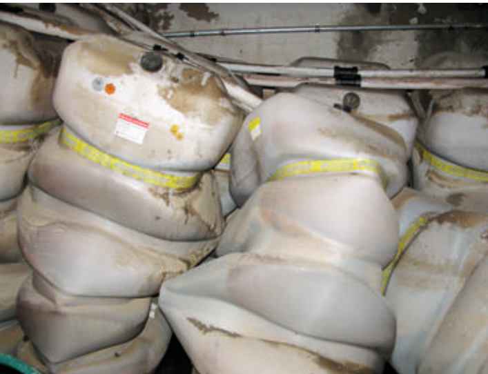
Zerstörte Heizöltanks infolge einer Hochwassereinwirkung
