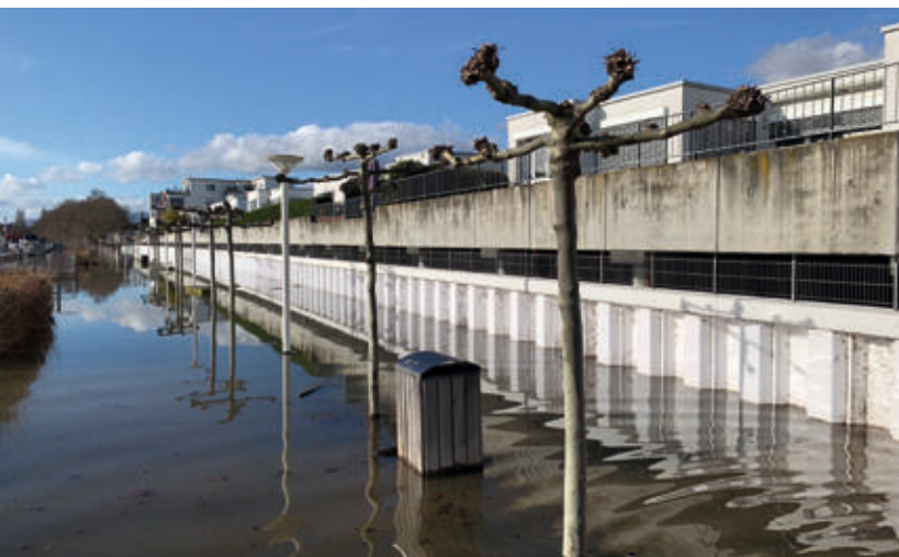
Hochwasserschutzwand mit eingerammter Stahlpundwand
