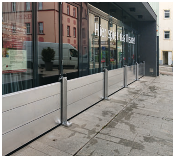
Objektschutz mit teilmobilen Schutzelementen
