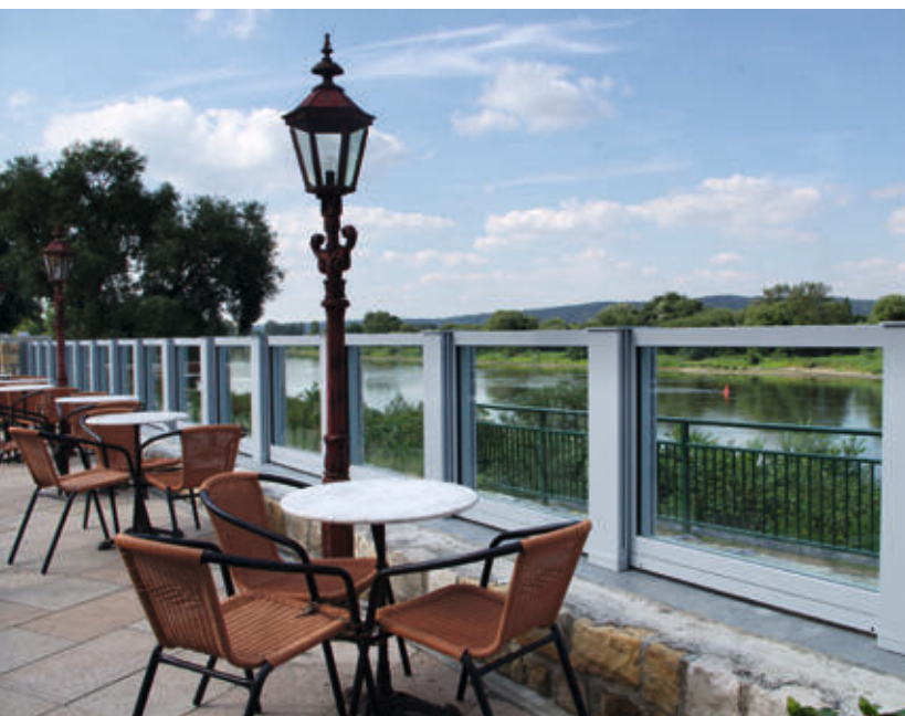
Hochwasserschutzwand mit Sicherheitsglas
