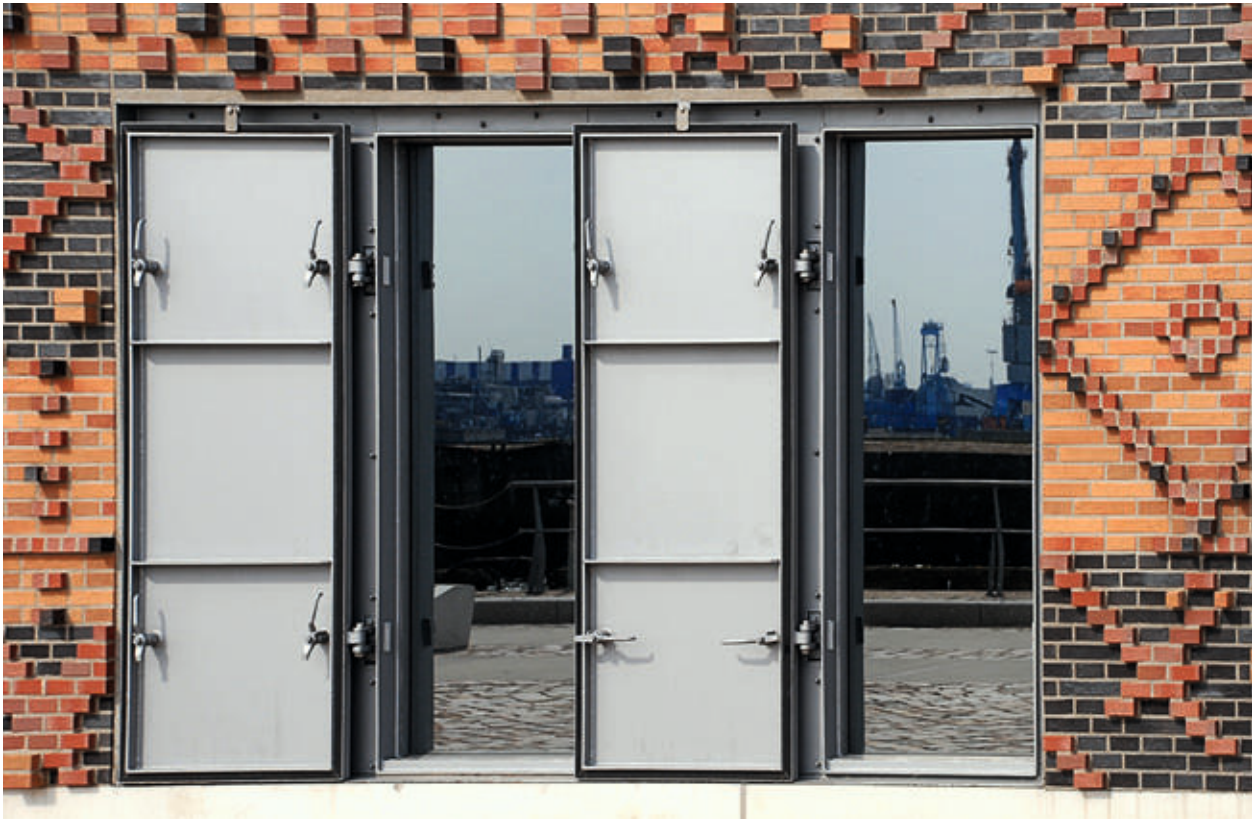
Integrierte Flutschutztüren
