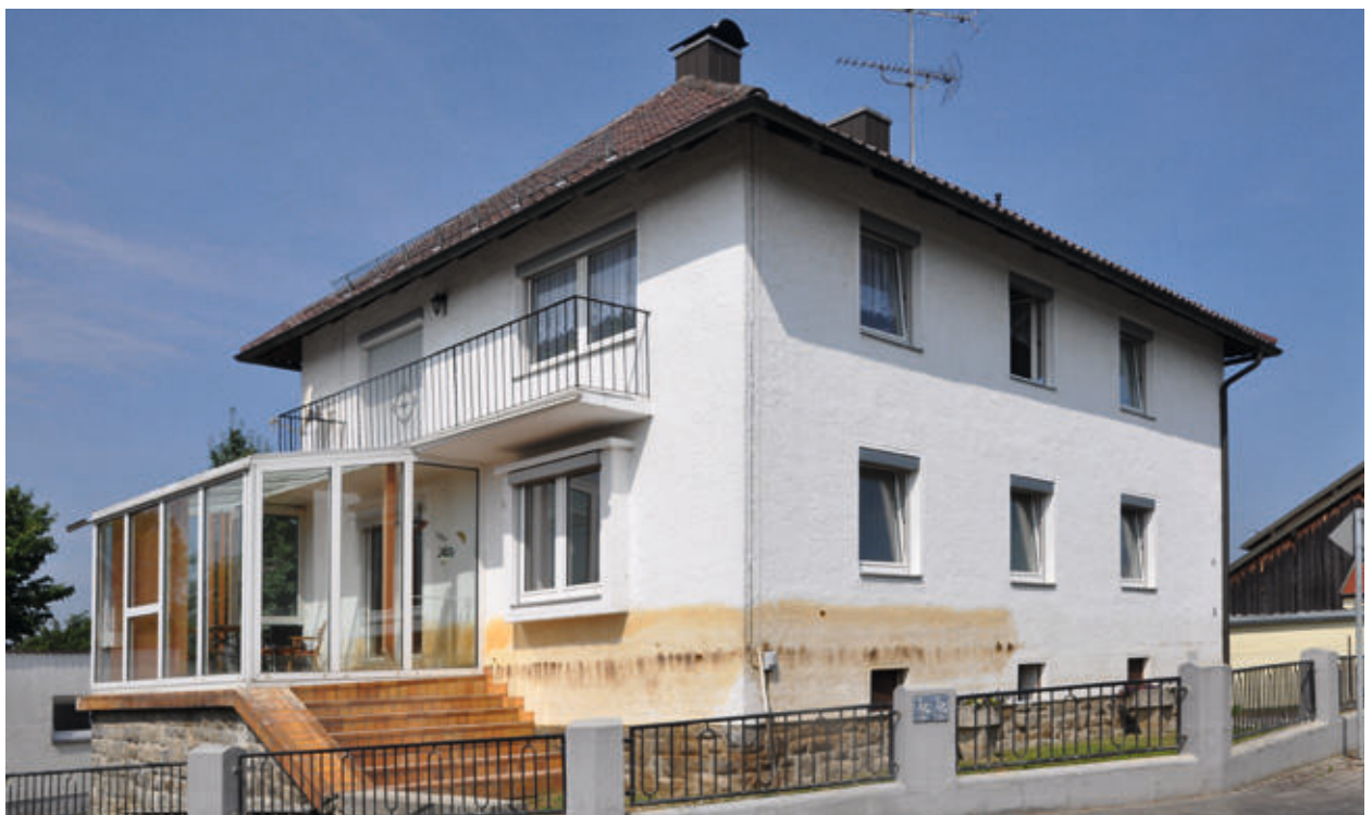
Mit Heizöl belastetes Wärmedämm-Verbundsystem eines Wohnhauses
