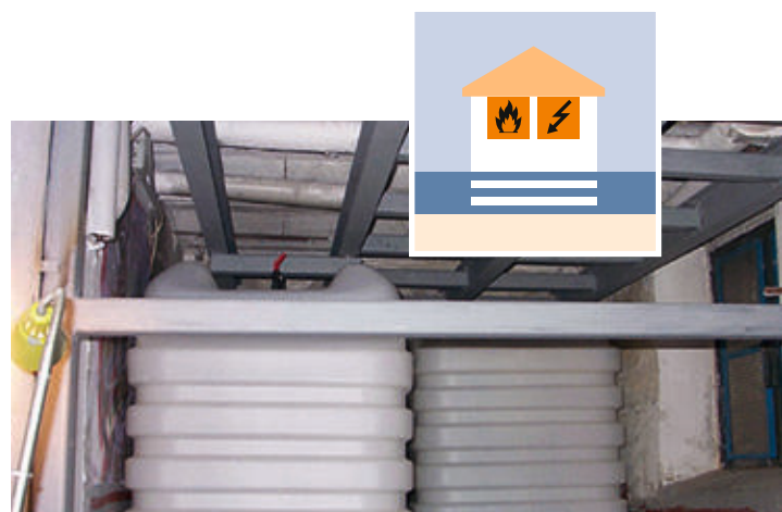
Anpassen: zum Beispiel durch Sicherung bestehender Tankanlagen
