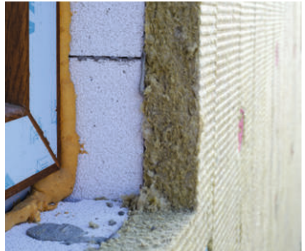
Einsatz von Mineralfaserplatten als Außenwanddämmung
