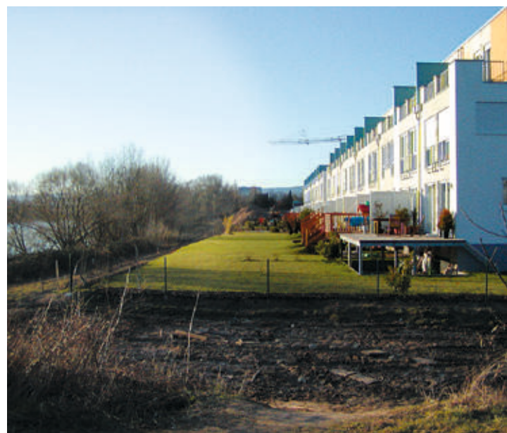
Hochwasserangepasste Bauweise mit erhöhtem Erdgeschoss
